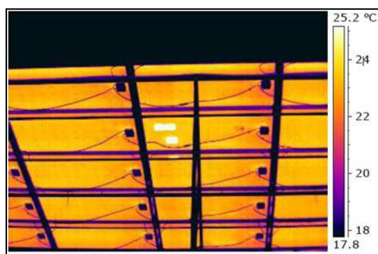
Obr. 37 Vadný sektor fotovoltaického panelu [2]
