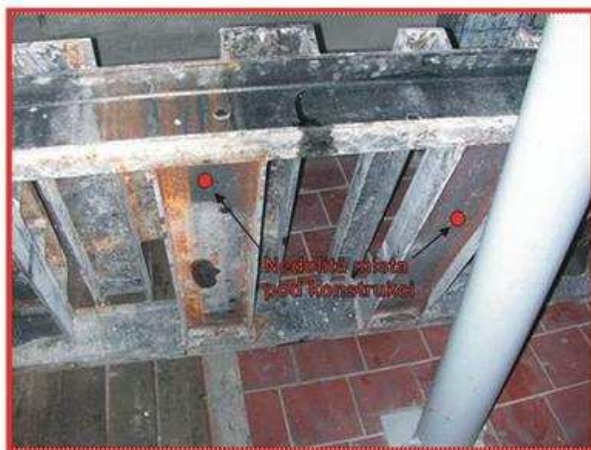
Obrázek č. 14. 22: Demontovaný základový rám soustrojí elektromotor – čerpadlo
