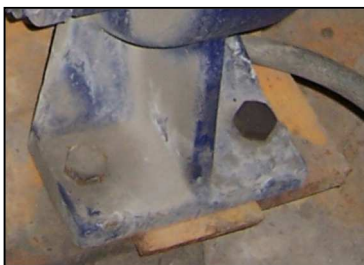
Obrázek č. 14.38: Ukázka špatně podložené patky čerpadla
