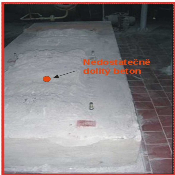
Obrázek č. 14. 21: Betonový základ po demontáži základového rámu soustrojí elektromotor – čerpadlo
