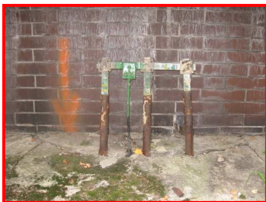
Zemniče Z1 – 49 \Omega , Z2 – 1,3 \Omega , Z3 – 0,3 \Omega , kulatý vodič – 60 \Omega
