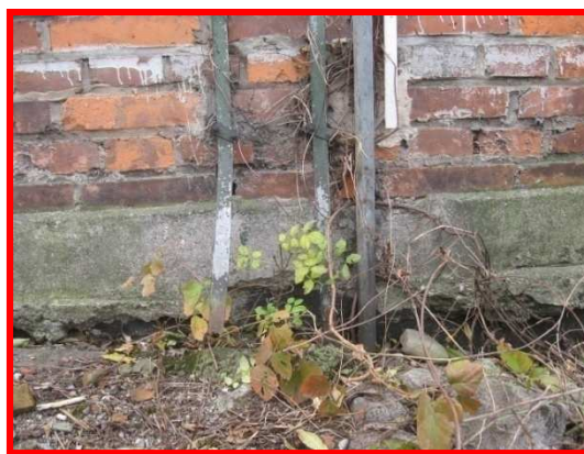
Zemnění – jeden zemnič uhnulý, druhý má hodnotu 157 \Omega
