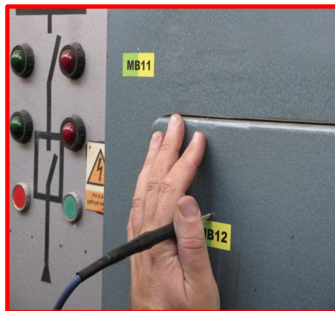
Obr. č. 10.: Měřící body uzemnění a dotykových napětí na rámu a dveřích transformátoru
