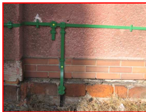
Zemnič ze zadní strany budovy rozvodny u čísla 7 – 30,5 \Omega Zemnič RZ5 = 91 \Omega
