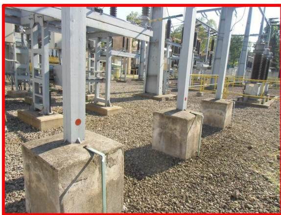
Obr. č. 7.: Označení měřících bodů na stožárech rozvodny 110 kV
