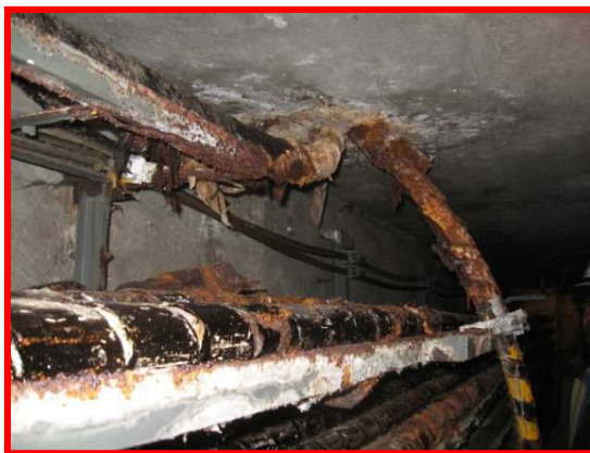
Prostupy ve stropě, zkorodovány lavice, zemnění a kovové obaly kabelů
