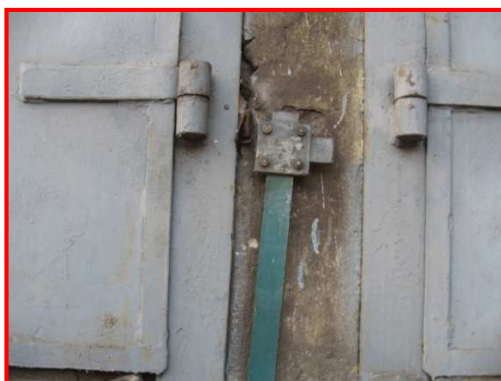
Mezi stanovišti transformátorů – přerušen zemničí pásek Uzemnění trafokobky – 42,7 \Omega ,
