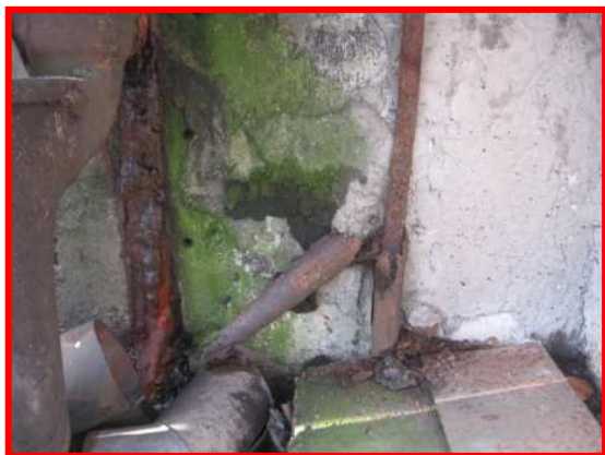
Zemnič – 8,2 \Omega , není chráněn proti mechanickému poškození ani korozi, silně napaden korozí
